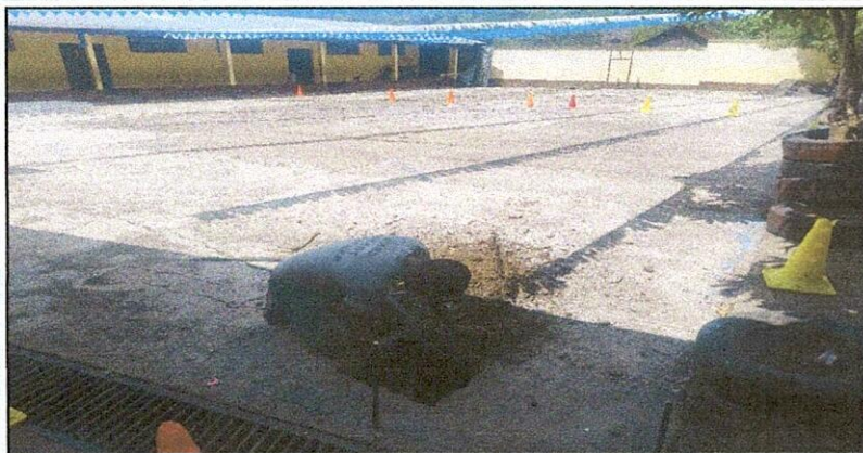
Foto 1: Excavación manual en cepas de dados donde se fundirán las columnas estructurales. Realizándose conforme a las medidas específicas.
